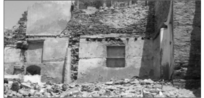
بعض البيوت القديمة المبنية بالحجر في شعب علي وقد أتت عليها معدات الهدم
